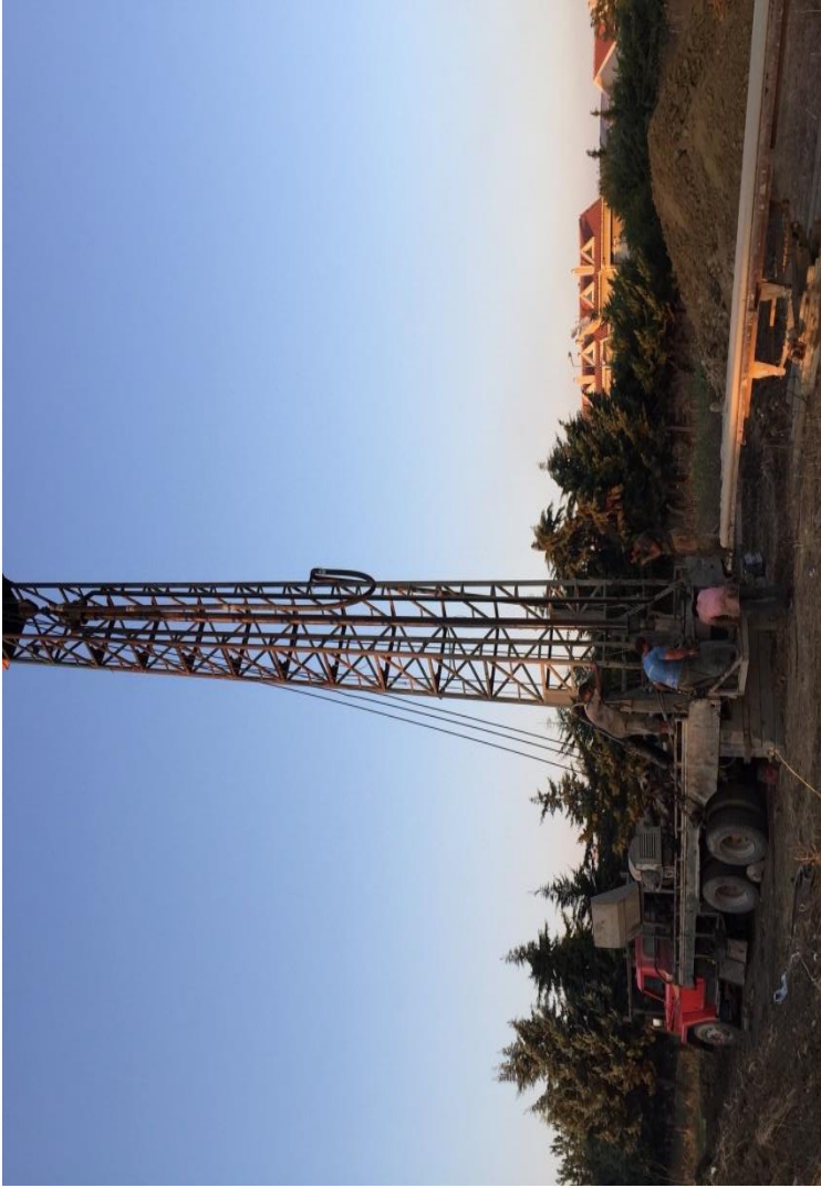
Celaliye İstasyonu Sismometre Sondajı 175 Mt
