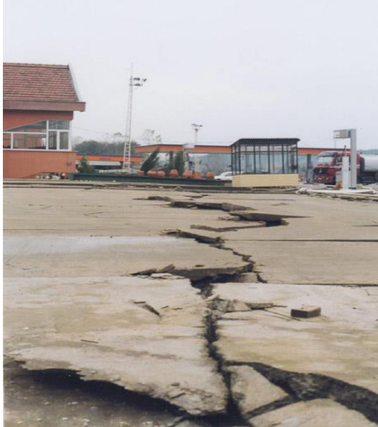
Şekil 23. Yanal atılımlı fay
